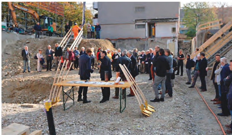
Die Baugrube ist ausgehoben. Nach den ersten Spatenstichen kann das neue Kirchenzentrum St. Christophorus realisiert werden.
